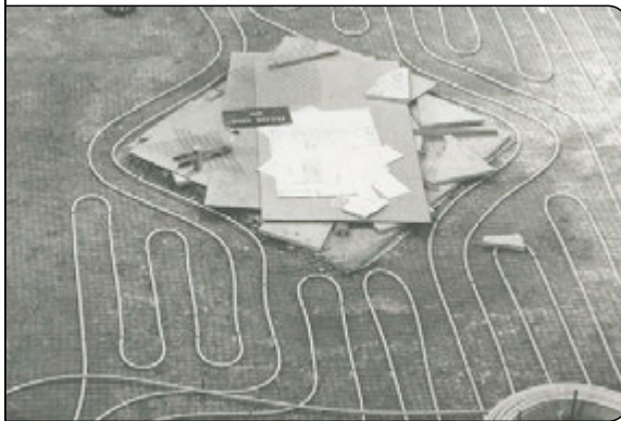
Blick auf die Verlegung der Heizrohre
