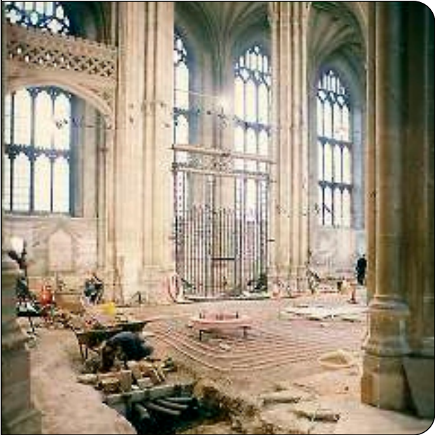
verlegte MB-Heizrohre
