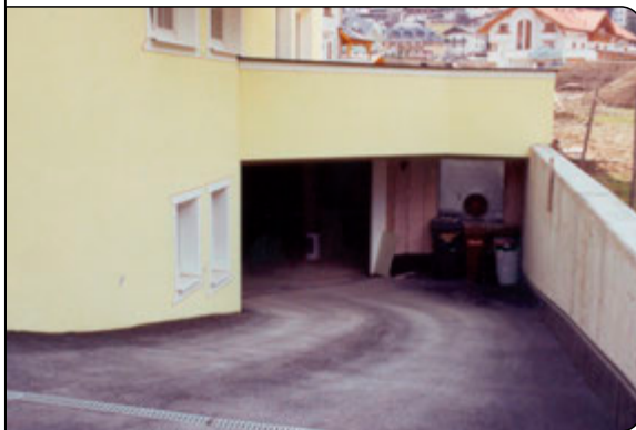
Fertige Garagenzufahrt des Hotels
