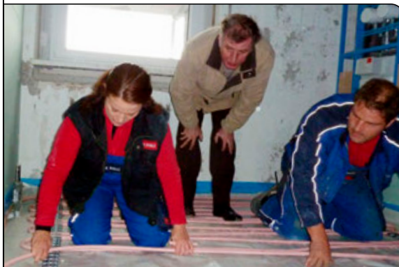
Verlegung der MB-Fußbodenheizung
